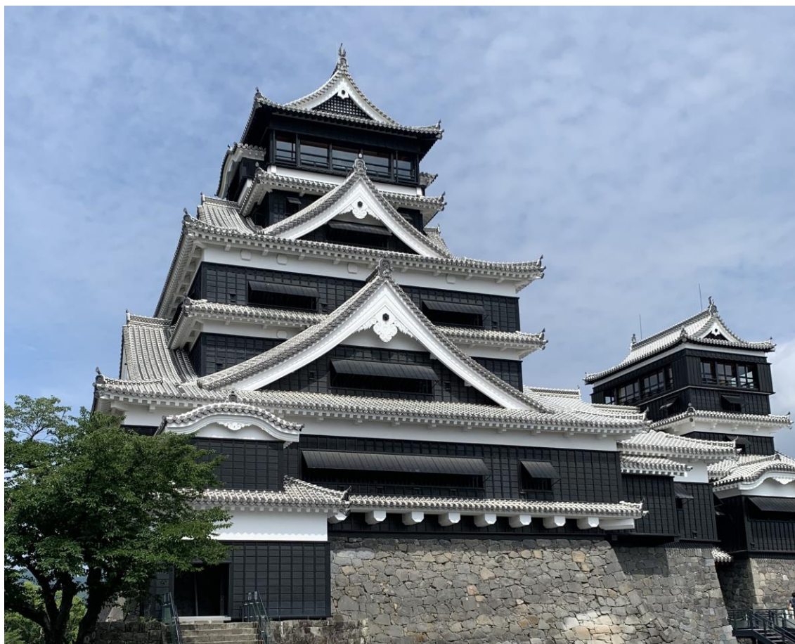
Fig.1 いち早く修復された天守閣。内部は近代的。
