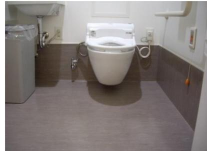
\*感染対策にて、壁から配管し、床部分にクリアランスを設けた。
